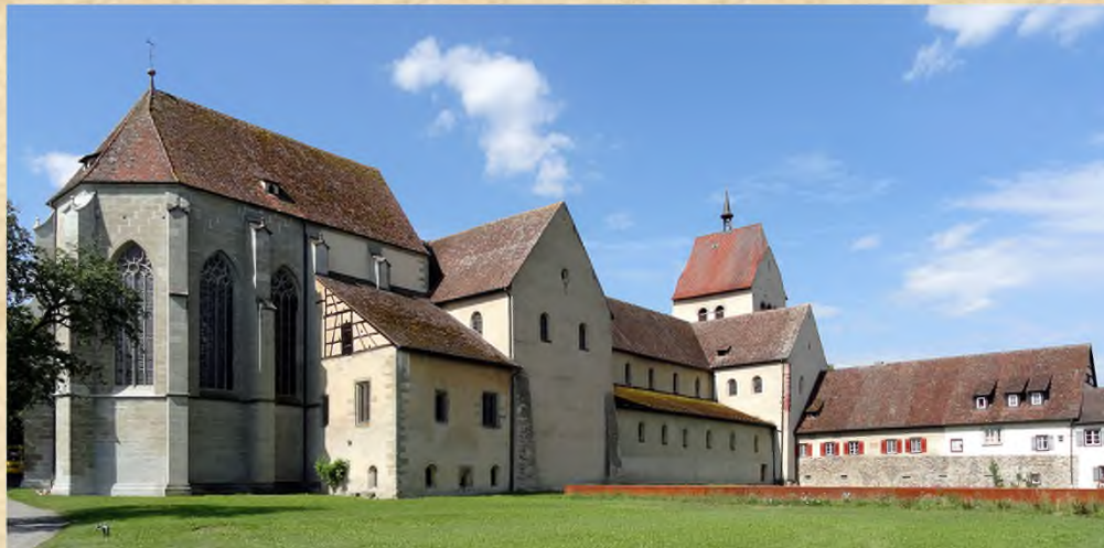
Klosteranlage auf der Insel Reichenau heute
